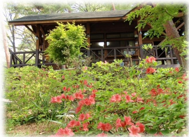
バーベキュー棟の外観
