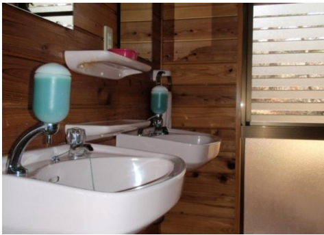
洗面所、10人棟は2つあります。
